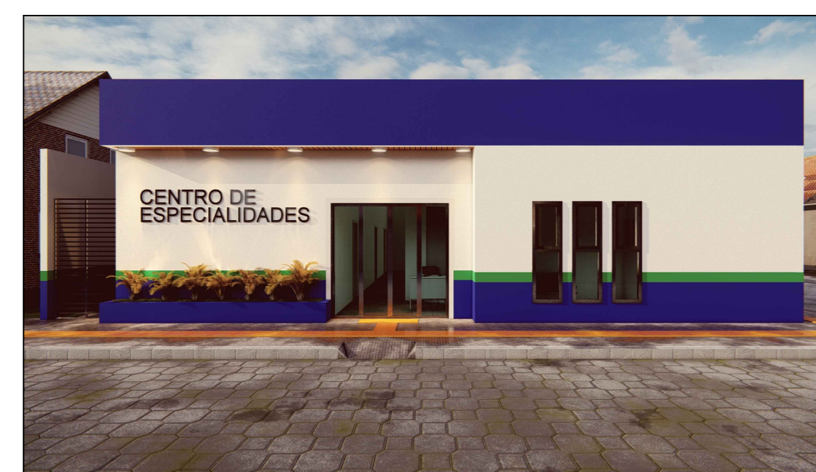
VISTA FACHADA FRONTAL
