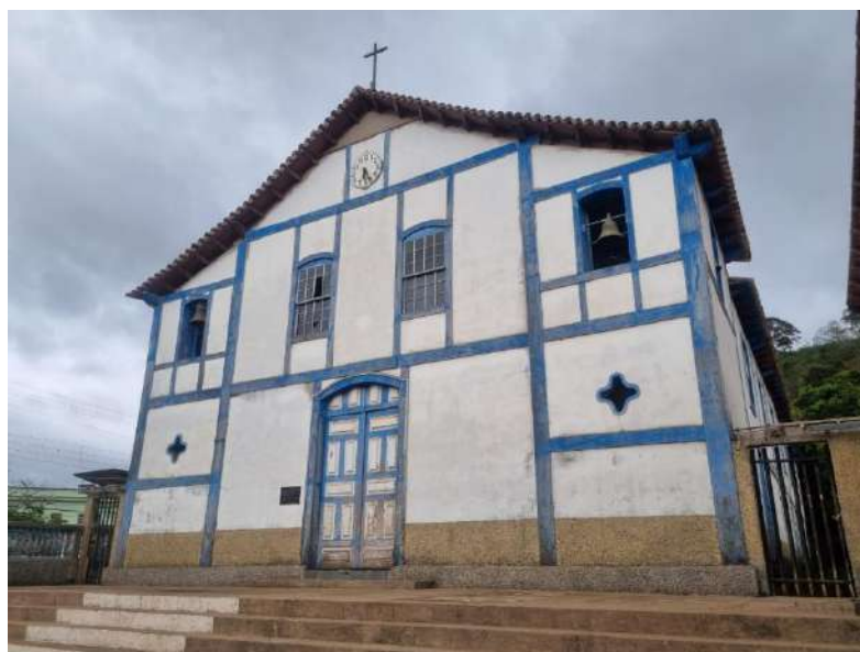
Imagem 51 - Fachada frontal da Capela
