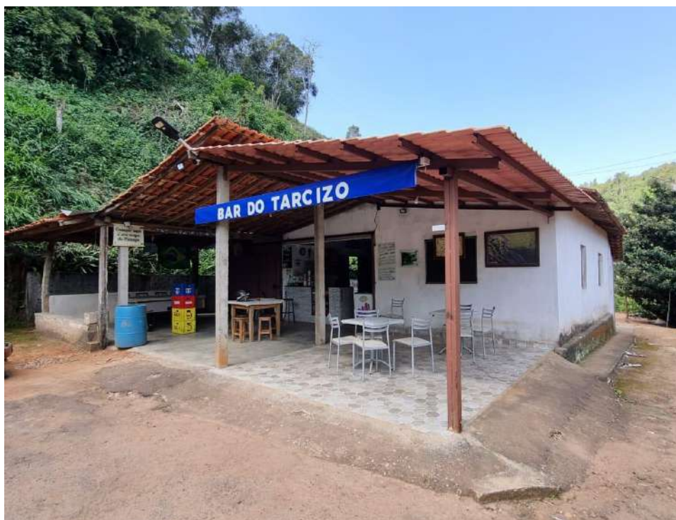
Imagem 8 - Estrutura do Bar do Tarcizo
