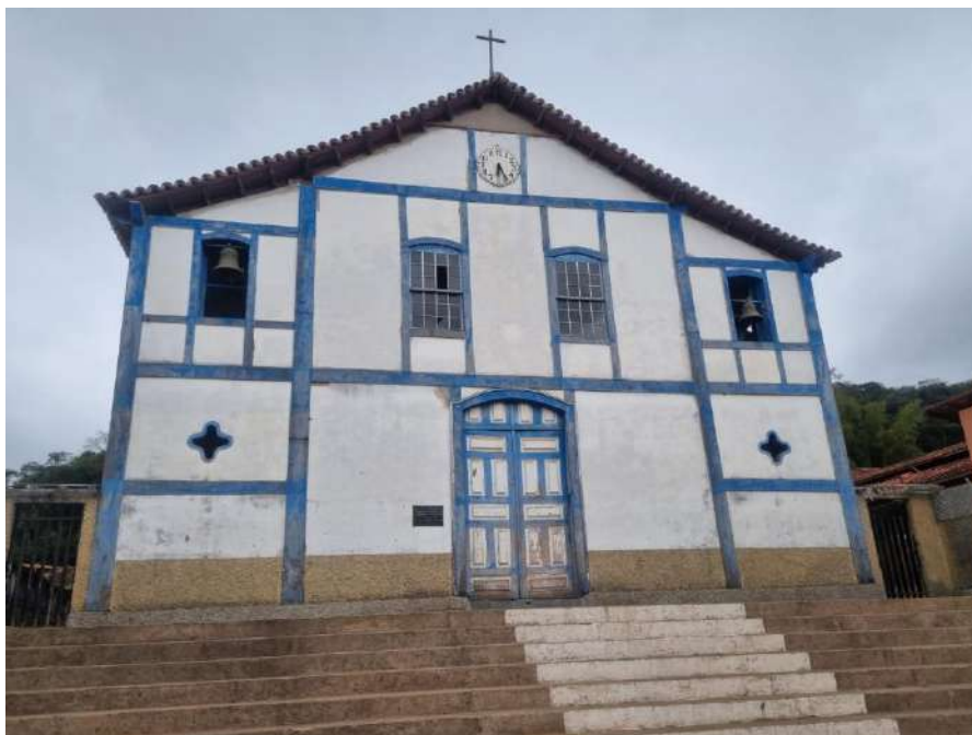
Imagem 50 - Fachada Frontal da Capela
