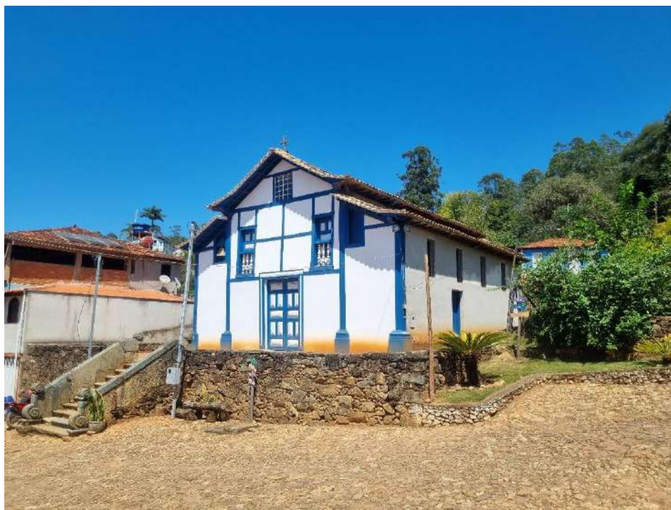
Imagem 32 – Fachada frontal e lateral
