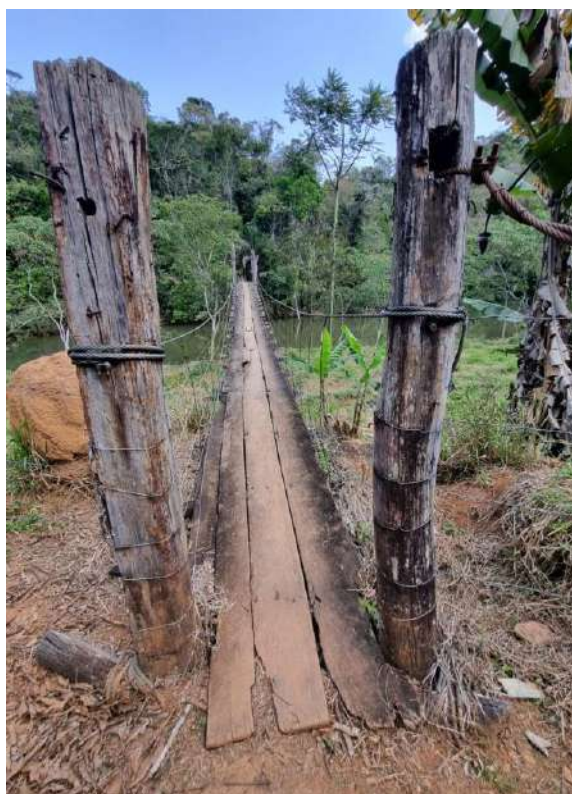
Imagem 6 - Ponte para acesso a cachoeira
