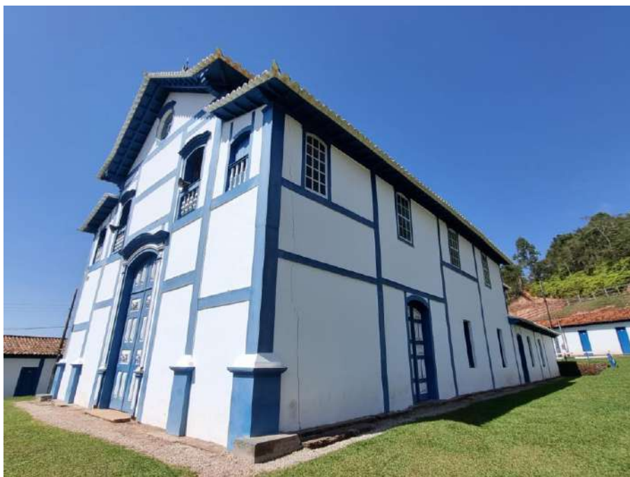
Imagem 19 – Fachadas frontal e lateral
